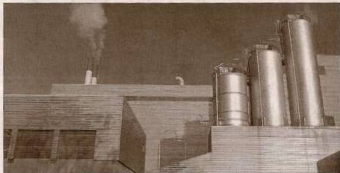
La pose prochaine d'un système de traitement catalytique des fumées de l'usine d'incinération de Sausheim constituera un lourd investissement pour le Sivom.
